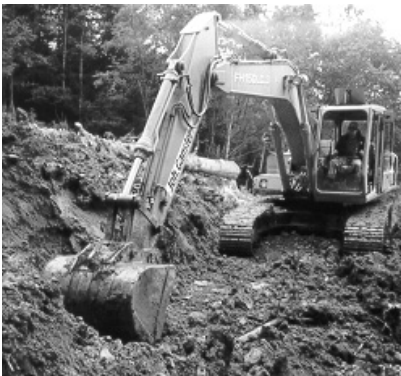
Umbauarbeiten an der Rodelbahn 1999
