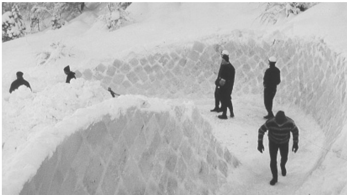
Bau einer Eis-Rodelbahn in Unterammergau
