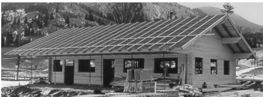
Fußballer-Vereinsheim im Rohbau
