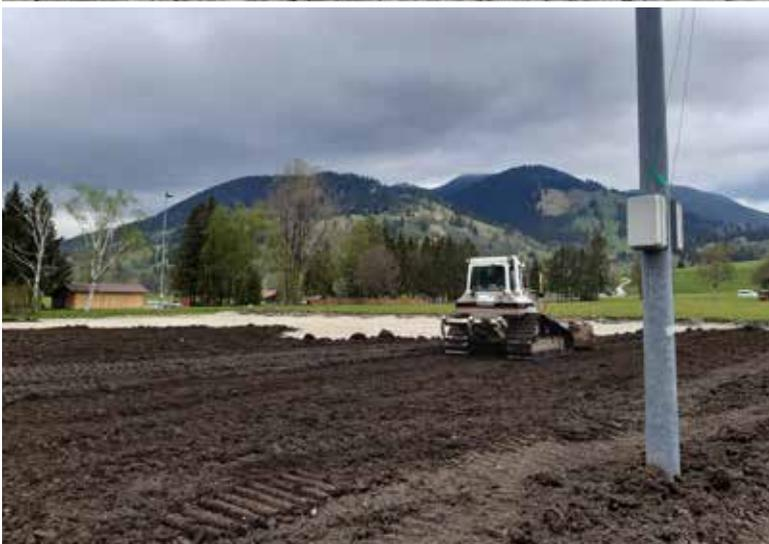
Arbeiten beginnen: Einbau der Drainagen, Aufbringen von Humus und Sand, Planieren, Ansäen, Düngen. Durch den schlechten Unterbau mussten zusätzlich 2700 Tonnen Kies und 700 Tonnen Sand für die Rasentragschicht aufgebracht werden, die Mehrkosten von 30 000 Euro verursachten. Hier war der Wettergott den Fußballern gottlob überaus wohlgesonnen: Trockenes, sonniges Wetter waren Grundlage dafür, dass die Arbeiten zügig voranschritten und zu einem guten Ende gebracht werden konnten.
